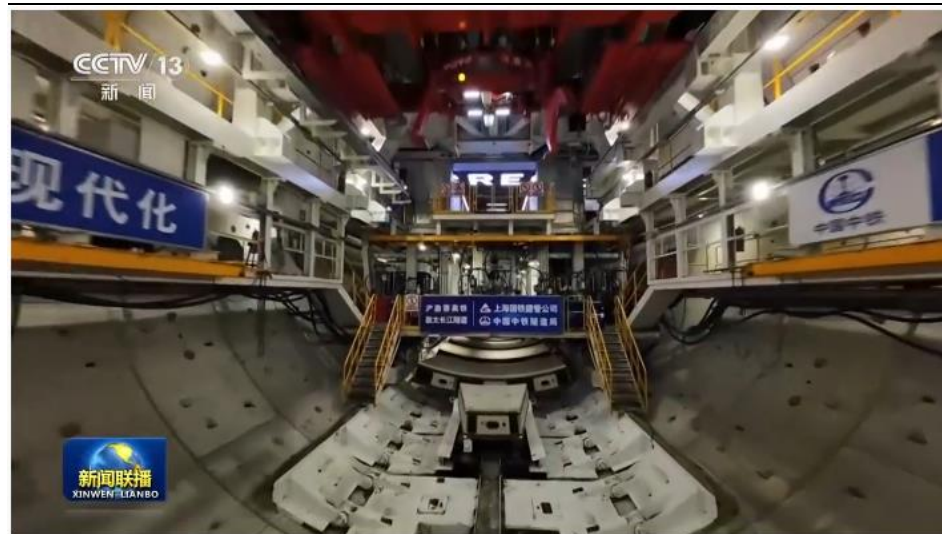
图2：高铁穿隧架桥，带动超200台（套）盾构机、造桥机等大型设备研发定制需求
